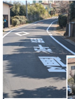
道路の修繕 (東部中学校裏)
