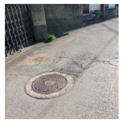
道路の修繕 松ヶ丘5-751
