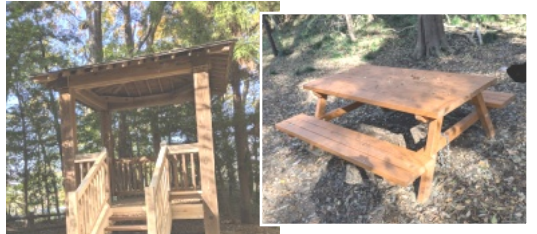
前ヶ崎城址 の修繕
