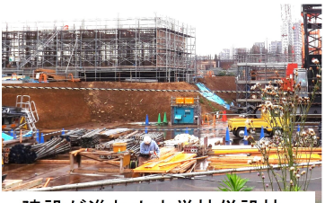
建設が進む小中学校併設校
