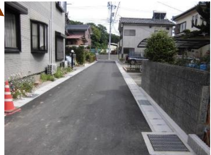
存置整備状況(施工後)
