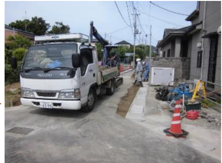
存置整備状況(施工中)
