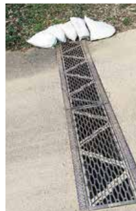
溢れる排水溝の解消（前ヶ崎740地先）高橋あきら
